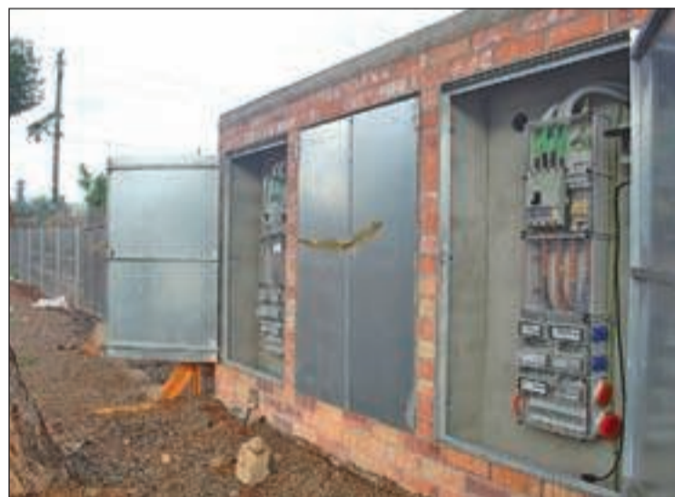
FOTO: Selena García / La instalación eléctrica, totalmente accesible
