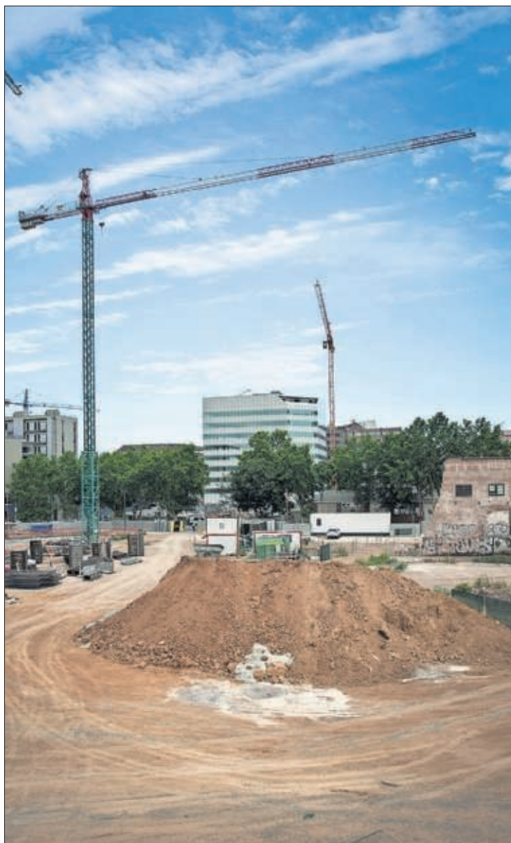
Obras de viviendas nuevas en la avenida Meridiana. / MASSILIANO MINOCRI
