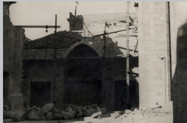
Visites als treballs de restauració i recuperació i col·locació de la clau de volta del creuer de l'església de Sant Pere
