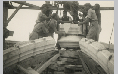
Visites als treballs de restauració i recuperació i col·locació de la clau de volta del creuer de l'església de Sant Pere
