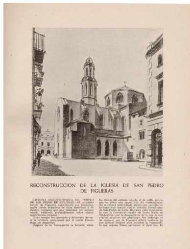
Reconstrucción de la iglesia de San Pedro de Figueras (Novembre 1942). Reconstrucción (27) pp. 407-418
