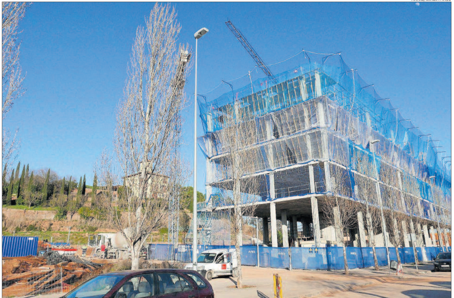
Un bloc en construcció al carrer Concòrdia de Manresa, en una de les darreres promocions d'habitatges iniciades a la ciutat
