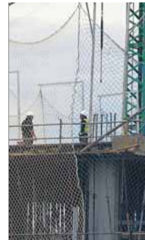
Edifici en obres i amb gent treballant-hi a finals de març a Girona ■ M. LLADÓ
