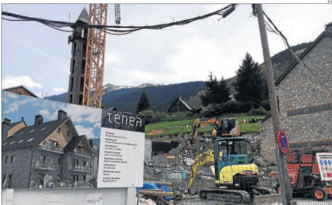
Imatge d'un grup d'habitatges en construcció a la capital aranesa.
