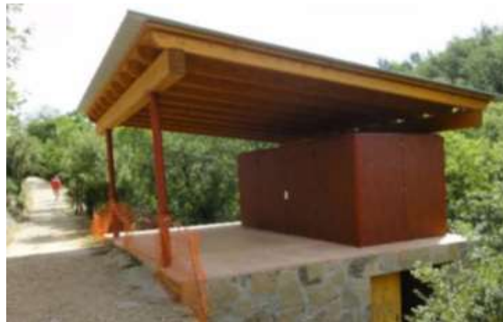
Pèrgola executada (núm.2, Món simbòlic)
